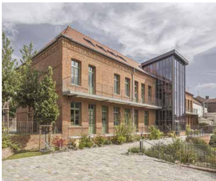
Réhabilitation d'une friche pour l'installation du siège de la Communauté de Communes Thiérache Sambre et Oise. Guise (02)
