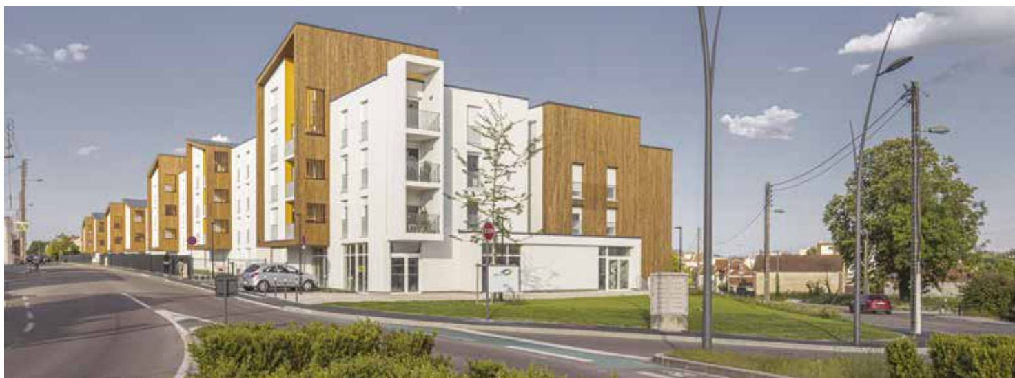
Opération de construction de 91 logements - Mon Logis. Troyes (10)
