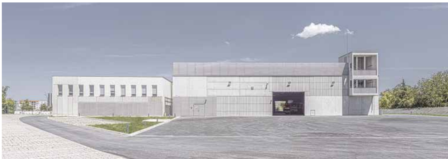
Centre d'Incendie et de Secours - Département de l'Aube. Sainte-Savine (10)
